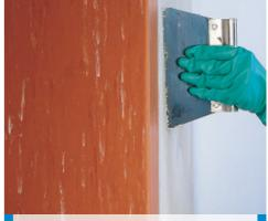
Stesura dell'adesivo dopo la posa del telo i n PVC risvoltato sullo spigolo
