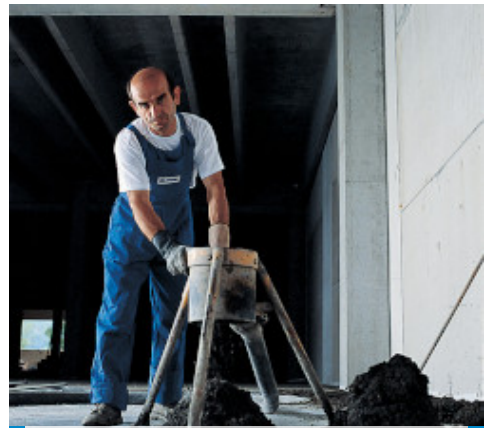
Batching a Mapecem mix
